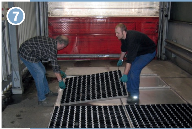
7 Roste mit Bürstenleisten in Wannen einlegen. Insert the grates with the brushes. Introduire les bandes avec les brosses dans les bacs. Introducir las bandas con los cepillos dentro de las cubetas.
