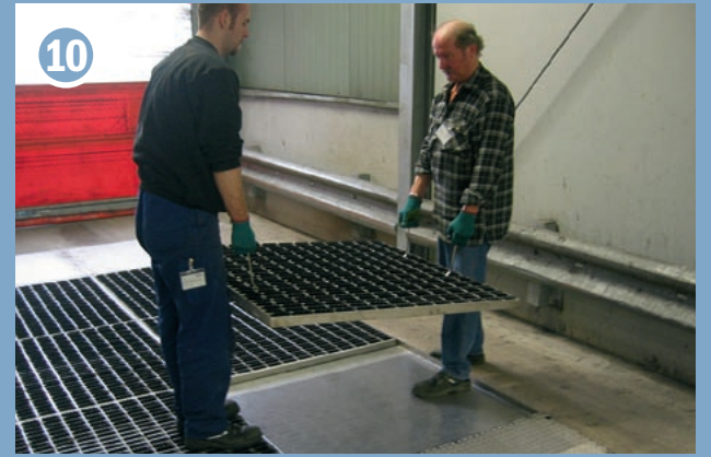
10 Zu Reinigungszwecken die Roste immer von zwei Personen entnehmen und wieder einlegen lassen Removing and Inserting the grates for cleaning purposes should always be done by two persons. Pour le nettoyage toujours soulever et reposer les caillebotis à deux personnes. Para la limpieza levantar y recolocar las rejillas siempre con dos personas.
